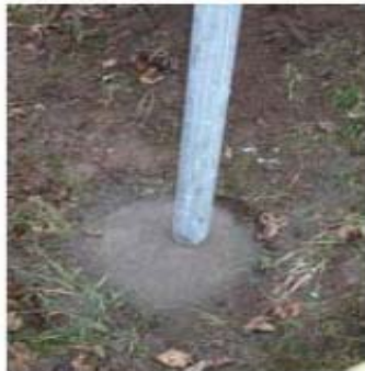
Betonfundament in Erdreich
