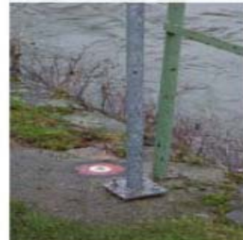
Fußplatte auf Betonuntergrund
