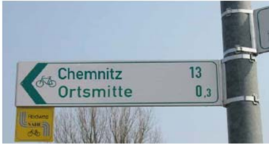
Pfeilwegweiser mit Stahlbandschellen an Lichtmast befestigt
