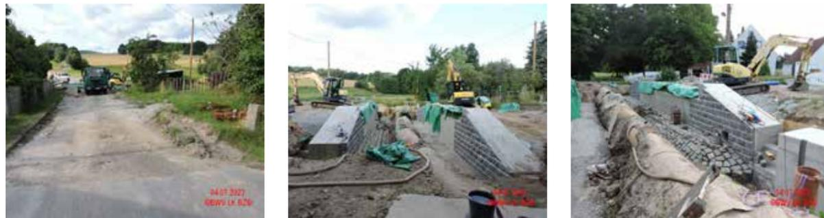
Bilder oben links: Blick aus Richtung Ortsmitte auf die Baustelle; oben mitte: Fertige Widerlager mit Flügeln – Herstellung der Otterberme; oben rechts: Links vor Widerlager – Auflagervorbereitung für das Traggerüst und Böschungstreppe mit anschließendem Wehrsockel für die Stauanlage rechts
